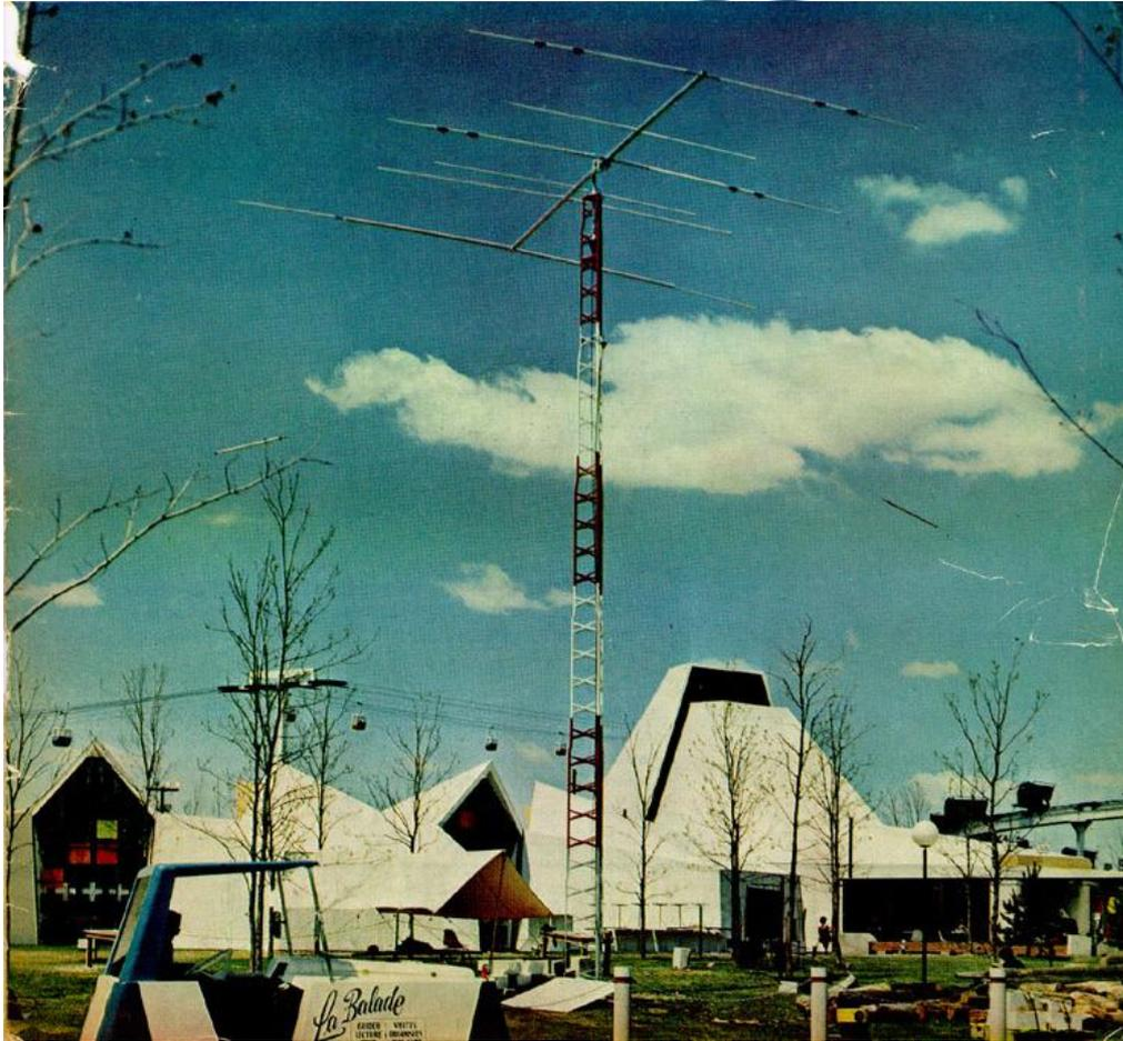
La station VE2XPO au Pavillon de la Jeunesse, sur l'Île Sainte-Hélène et la fameuse antenne tribande 10-15-20 mètres, 6 éléments, modèle TM-30D de la Cie TELREX, au sommet de la tour DELHI, modèle DMX-48HD
